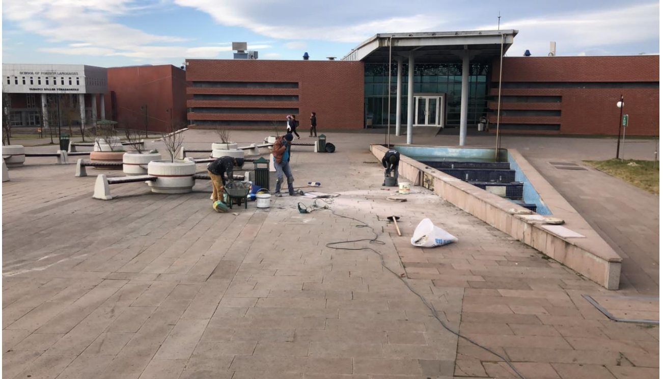
Büyük Onarım 2021 ihalesi kapsamında yapılan işlere ait görseller
