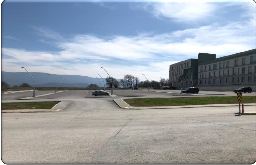
Kampüs Altyapısı kapsamında yapılmış işlere ait görsellerden
