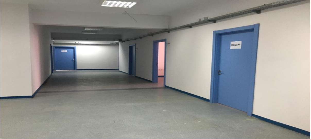
Eski Kütüphane Binası büyük onarımına ait görsel
